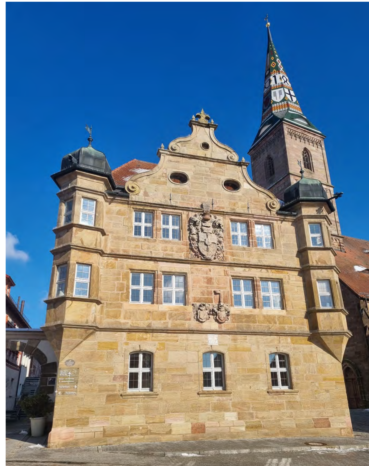
RESTAURIERUNGSARBEITEN AN DER SÜDLICHEN SCHMUCKFASADE DES RATHAUSES IN WOLFRAMS-ESCHENBACH
