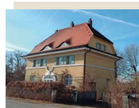
KLEIN: DAS ANWESEN IN DER SEESHAUPTER STRASSE 45 IN DER GEMEINDE IFFELDORF. GROSS: DAS ANWESEN NACH DER ABGESCHLOSSENEN FASSADEN- UND FENSTERSANIERUNG.
