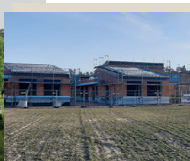
GROSS: ANIMATION DES VOLLENDETEN BAUS DES NACHSORGEZENTRUMS FÜR EHEM. KREBSKRANKE KINDER IM BRENNTHAL. KLEIN: BAUPROZESS DES NACHSORGEZENTRUMS IN DER GEMEINDE ZEITLARN.
